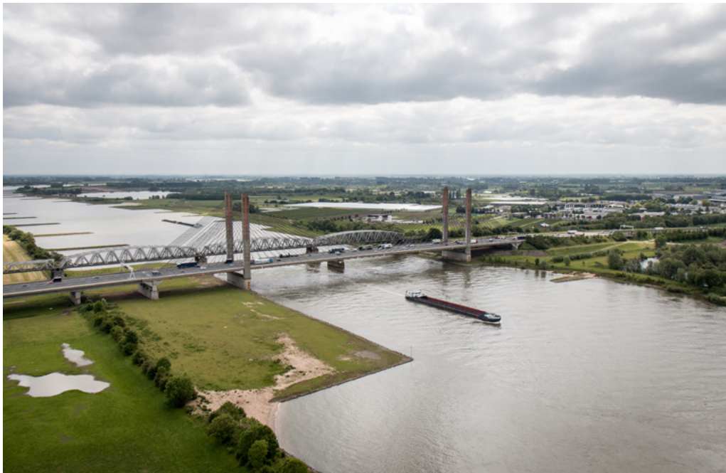
De Martinus-Nijhoffbrug over de Waal
